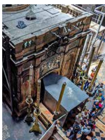
Le tombeau du Christ restera ouvert au public pendant la restauration. Keystone
